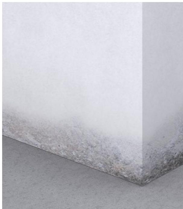
Rimozione della malta ammalorata ed il suo ripristino con specifico intonaco da zoccolatura.
