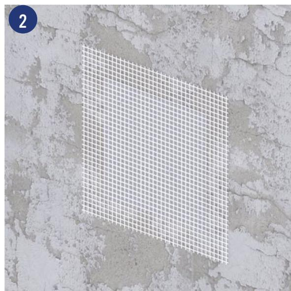
A distanza di almeno 3 giorni, si procederà con una prova manuale a strappo verificando che rimanga tutto il primo strato di collante sul supporto e venga rimossa unicamente la rete e lo strato di collante in superficie.
