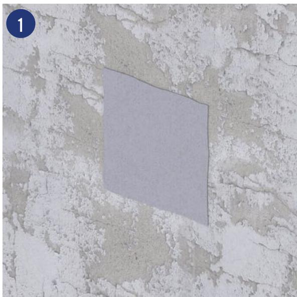
Per effettuare la prova di resistenza, stendere una prima mano di rasante/collante su una superficie di circa 50x50 cm.
